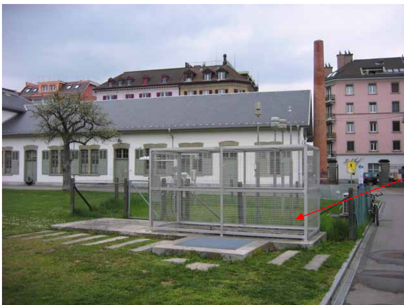
Abb. 2-45: Messstation Zürich (Messstation unterirdisch)
