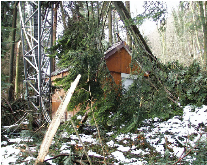
Abb. 2-21: "Lothar-Folgen" Beeinträchtigung der Station Lägeren durch den Sturm Lothar (26.12.1999)
