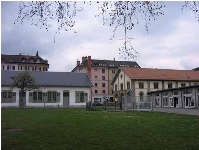
Abb. 2-44: Messstation Zürich, Zeughaushof
