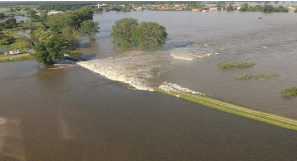
Abb. 1: Deichbruch Fischbeck 2013 (Jüpner 2013)
