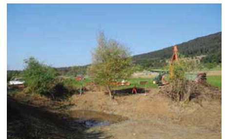
Abb. 1: Weihersanierung in der Gesamtmelioration Blauen BL, © LZE, Ressort Melioration.
