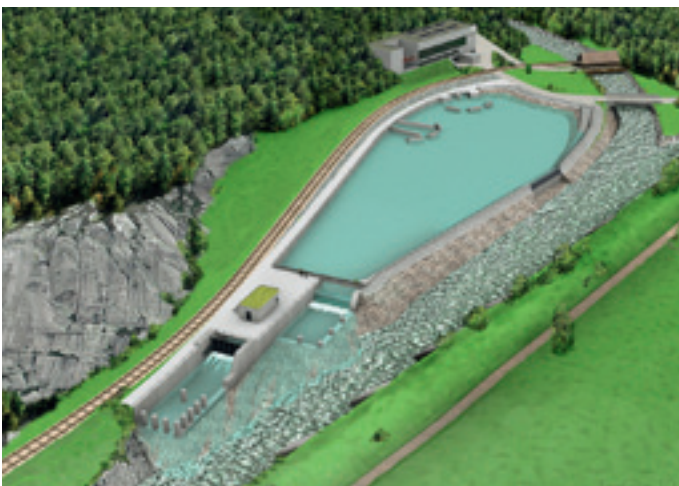
Abb. 4: Illustration eines möglichen Beruhigungsbeckens [8]. Im Vordergrund von rechts oben nach links unten ist die Aare bei Innertkirchen zu erkennen, in die das Gadmerwasser einmündet. Mit einem Volumen des Beckens von rund 50 000 Kubikmetern liesse sich das Schwall-Sunk-Verhältnis von 8:1 auf 5:1 verbessern.
