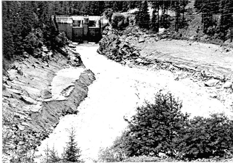
*Abbildung 3.24 Wehr und unterer Staubereich des Ausgleichsbeckens Ferrera während der Spülung vom 6. August 1985. Restbestände der äusseren Kolmation. Blick in Fliessrichtung. Foto aus Kraftwerke Hinterrhein AG (1985).*
