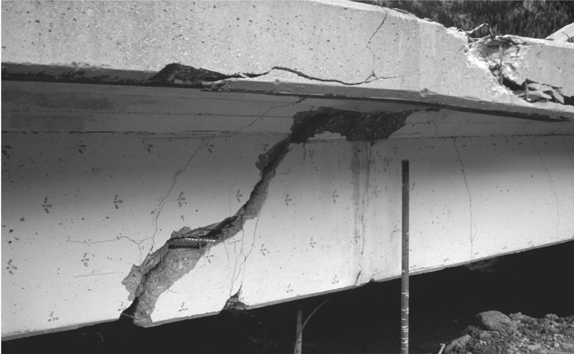
Bild 4.18 Südlicher äusserer Steg der Brücke nach dem Bruch
