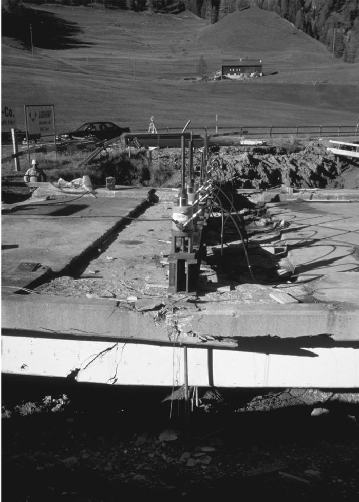
*Bild 5.1 Steilerbachbrücke mit der Lasteinleitung nach dem Bruch
