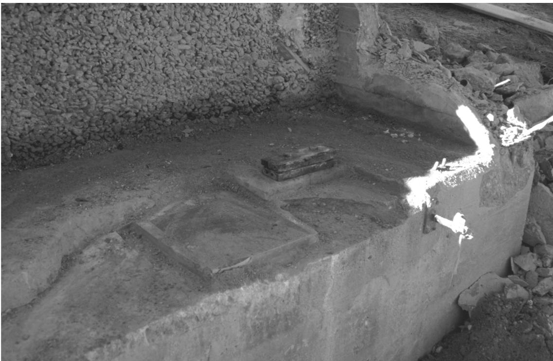
*Bild 3.6 Auflager des nördlichsten Steges nach dem Abbruch der Überbaus*
