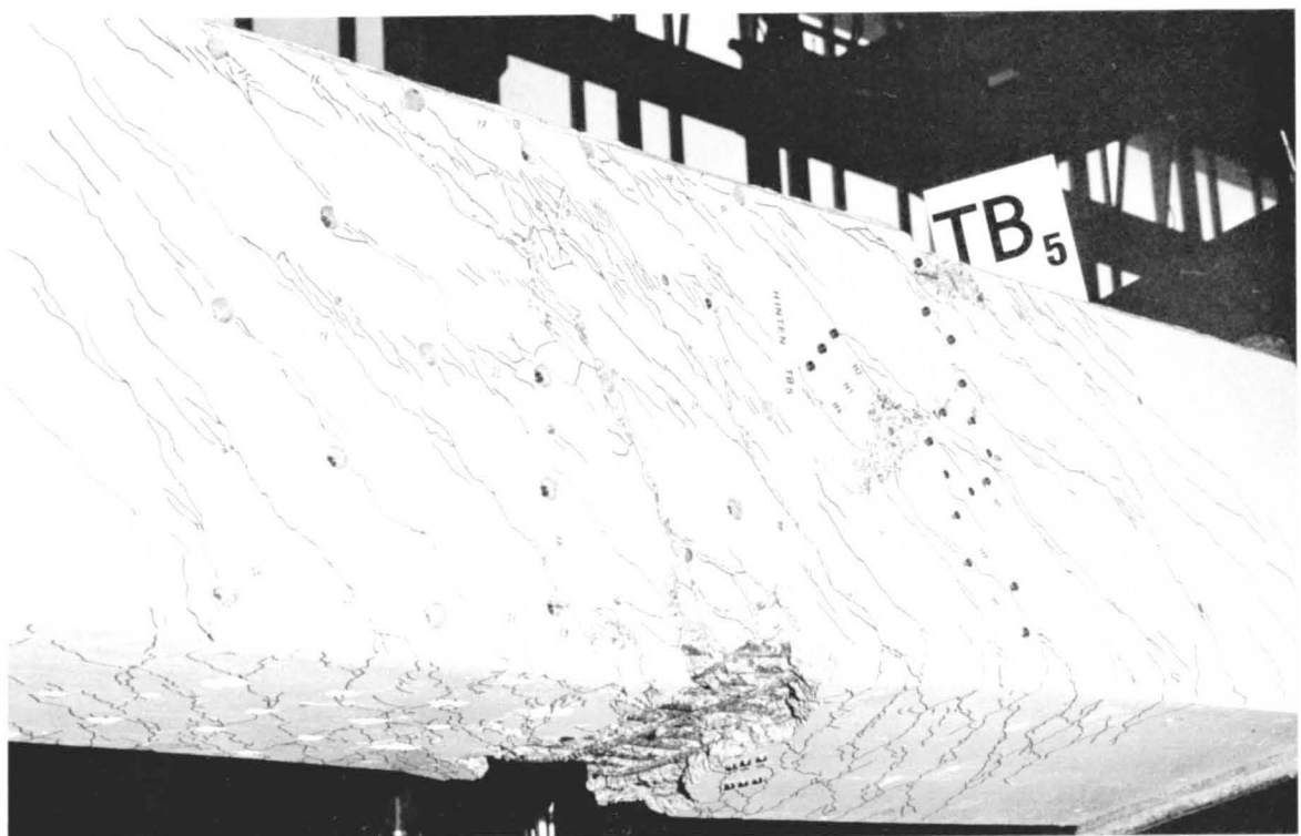
Bild 24 (b) : Bruchbereich Balken TB 5 (hinten, unten)
