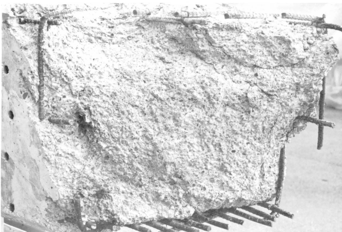
Bild 19: „Bruchfläche“ Balken TB 4
