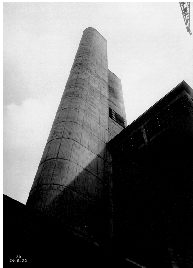
Hochkamin des Maschinenlaboratoriums ETH Zürich, Architekt: O. R. Salvisberg, Quelle gta.
