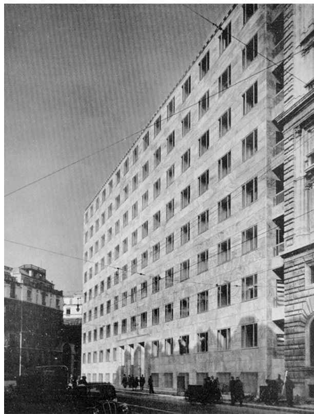
Mailänderhochhaus des Montecatini Konzerns, Architekt: Gio Ponti, Quelle: Baumeister 1939/6 S. 184.
