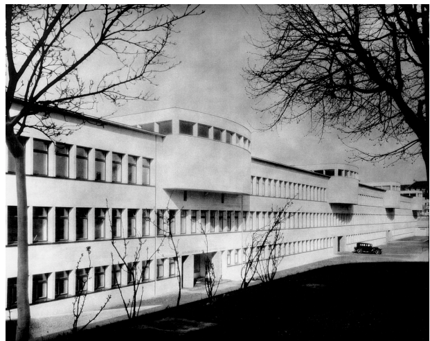
Uni Bern, Fenster Nordseite, Architekt: O.R. Salvisberg, Quelle: gta.
