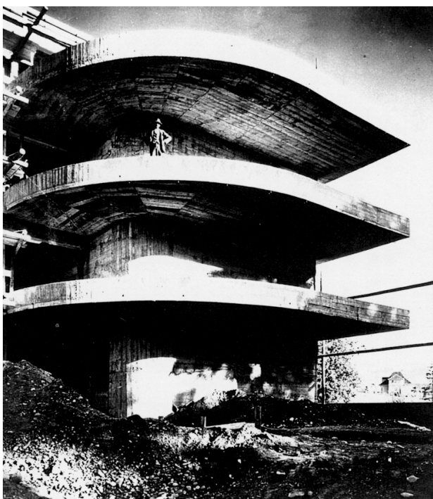
Lory- Spital, Liegehallen im Rohbau, Architekt: O. R. Salvisberg, Quelle gta.
