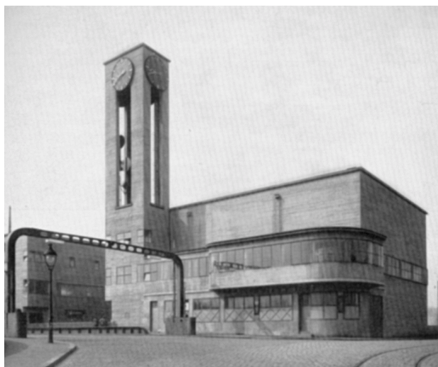
Marientorschleuse Duisburg, Architekten Becker und Kutzner, Quelle: Baukunst 1931/4, S. 121.
