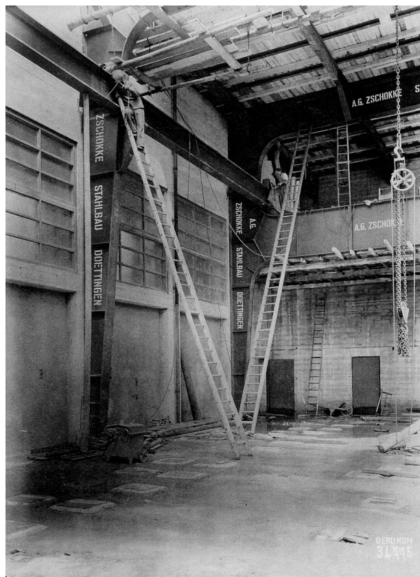
Maschinenhalle im Rohbau, Quelle: gta.
