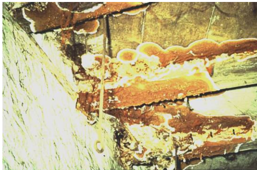
Abbildung 47 Fruchtkörper des E.H. an Deckenbalken
