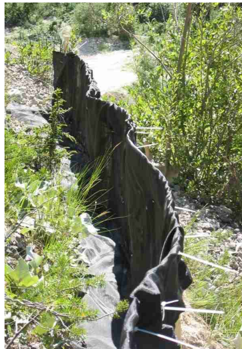
Figure 4-23 Silt fence plot F1 (Corina Gwerder)
