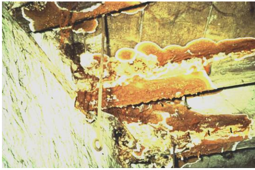
Abbildung 2.67 Fruchtkörper des E.H. an Deckenbalken
