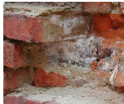
Abbildung 2.66 Vom E.H. durchwachsenes Mauerwerk (Quelle: www.holzfragen.de)
