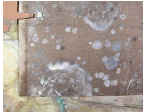
Abbildung 2.52 Schimmelpilze auf Spanplatte (Quelle: www.holzfragen.de)
