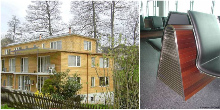
Abbildung 2.97 Einsatzbeispiele für thermisch vergütetes Holz in der Schweiz (Mehrfamilienhaus, AG. Sitzreihen im Flughafen Zürich-Kloten)
