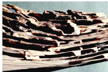
Abbildung 2.79 Durch Pilze und Ameisen zerstörtes Stück Holz
