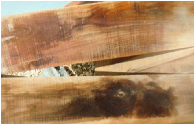
Abbildung 2.9: Verfärbung von Holz durch unsachgemässe Lagerung
