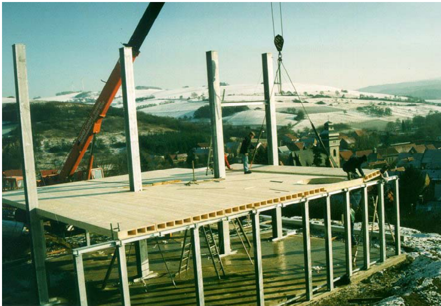
Abbildung 7.7 Decke in Hohlkastenkonstruktion, Fa. Lignatur, Schweiz
