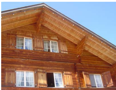
Abbildung 2.47 Braune Fassade unter Dach
