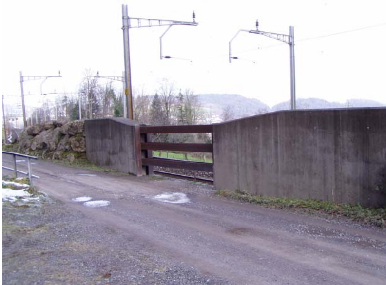
Abb. 5-1: Geschieberückhaltewand oberhalb der SBB-Linie Immensee-Arth
