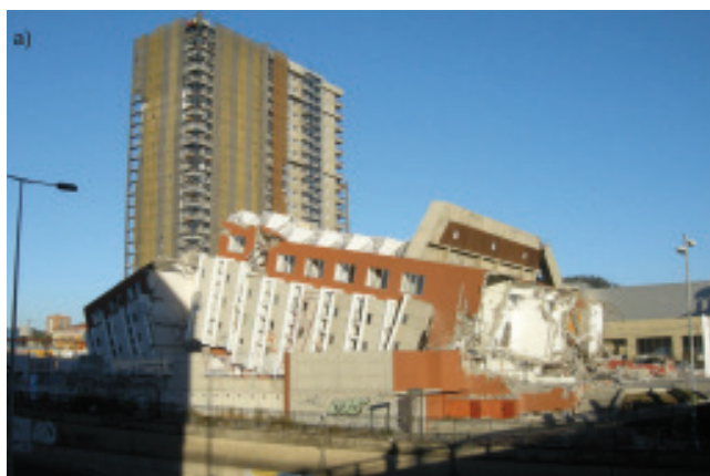
Bild 9. 15-stöckige Stahlbetontragwandgebäude Alto Rio in Concepción: Ansicht des nach links umgestürzten Gebäudes (a) und abgerissene Wände im Erdgeschoss (b).
