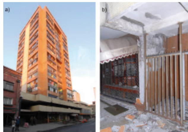
Bild 8. 17-stöckiges Stahlbetontragwandgebäude Torre Libertad in Concepción: Ansicht (a) und Biege-Druckversagen einer Wand im Erdgeschoss (b).
