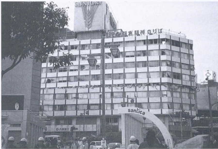
Bild 17. Geschäftshaus mit Mittelgeschosseinsturz
