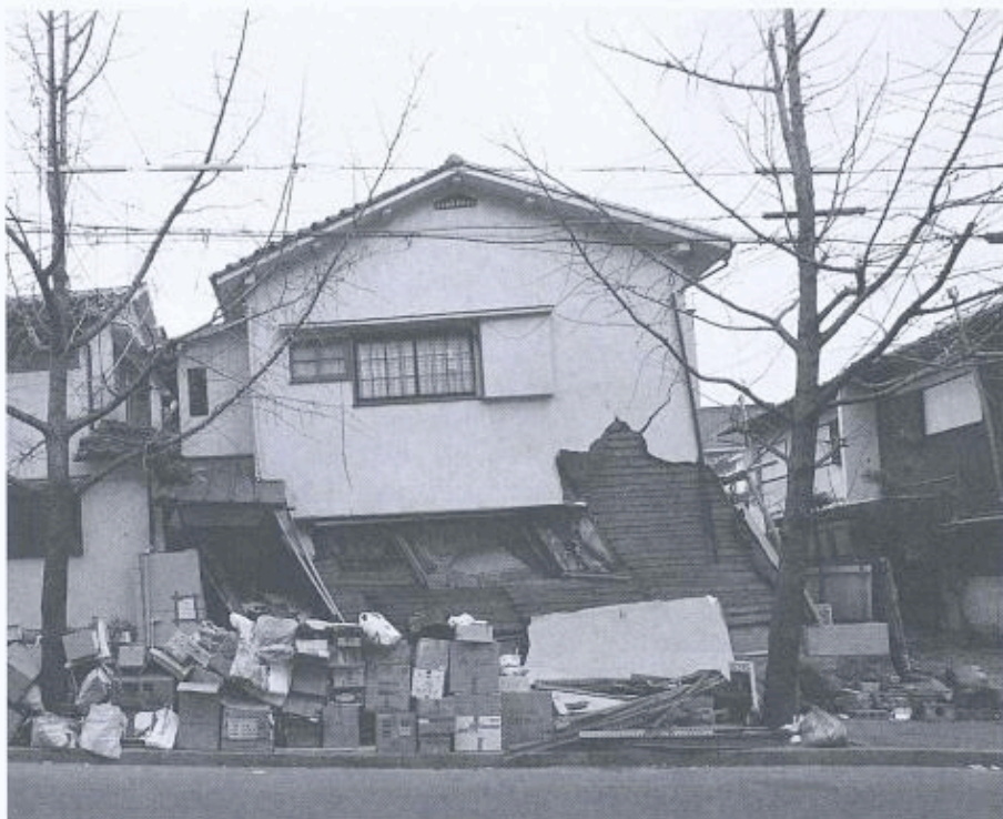
Bild 14. Nach links gekipptes Holzhaus («soft-story»-Effekt)
