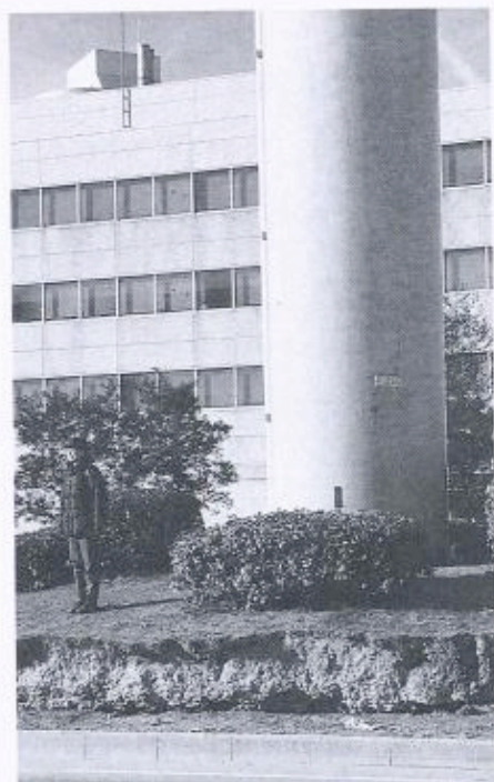
Bild 4. Setzungen infolge Bodenverflüssigung auf Port-Island
