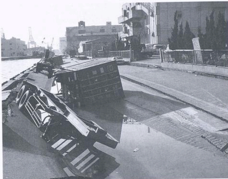
Bild 5. Umfangreiche horizontale und vertikale Bodenverschiebungen infolge Versagen der Hafenanlagen auf Port-Island
