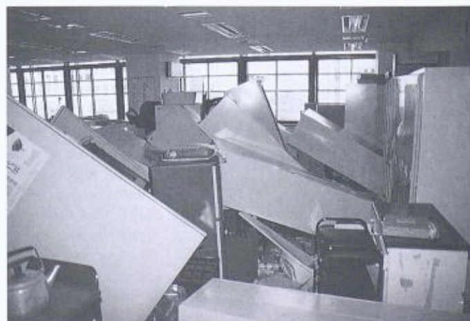
Bild 16. Umgestürzte Büromöbel in Gebäude von Bild 15
