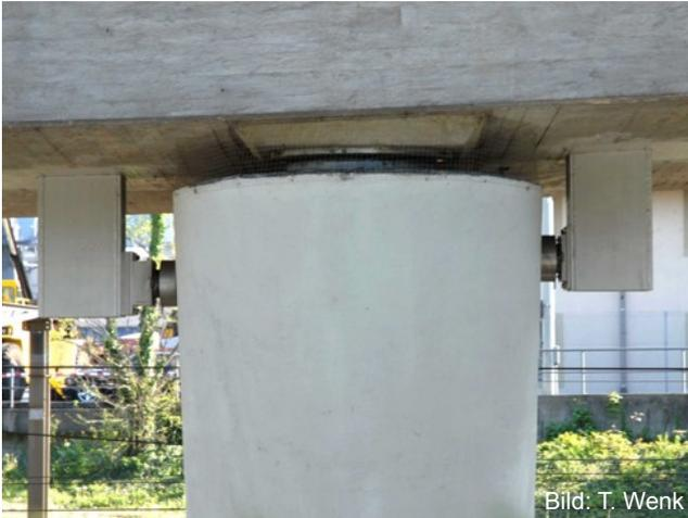
Eine der beiden Mittelstützen mit nachträglich eingebauten seitlichen Nocken
