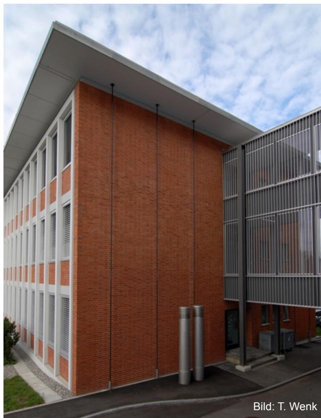
Mauerwerkswand der Stirnfassade verstärkt mittels aussenliegender Vorspannung durch 5 CFK-Spannglieder.
