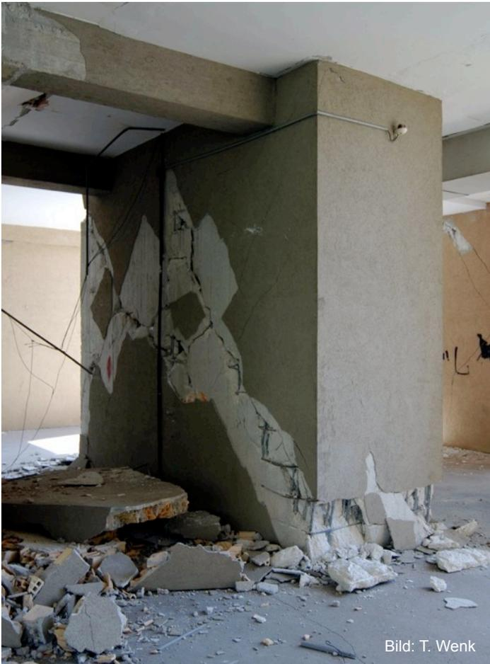
**Schubbruch am Fuss eines Liftkerns eines fünf-stöckigen MFH mit Stahlbetonkernen beim Erdbeben in L'Aquila 2009**
