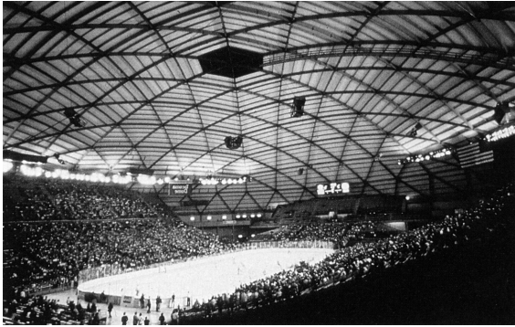
Abb. 27: a) links: Tacoma Dome, Tacoma, McGranahan Messinger Ass., 1983 [30], Tragwerk mit dem System eines Einfachen Gitters, bei welchem die Stäbe gleiche, regelmässige Dreiecke umschreiben; b) rechts: Einfaches Gitter, bei welchem die Stäbe verschiedenartige Sechsecke umschreiben [47].
