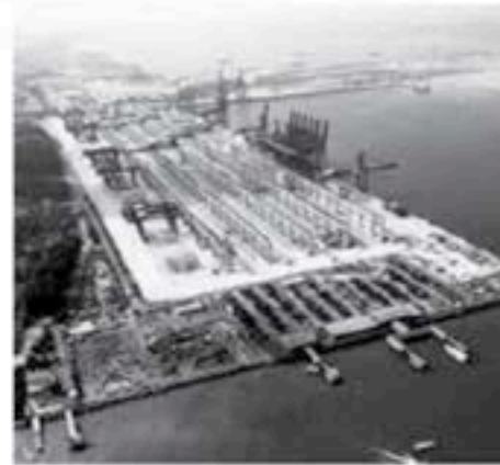
Container Hub: Pasir Panjang
