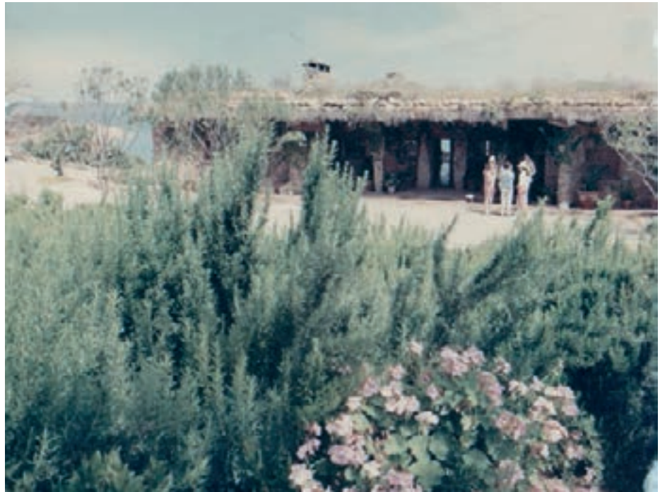
A Der Eingang des Hauptgebäudes des Hotels Pitrizza. Der Zugang erfolgt unter dem auskragenden Gründach in den flachen Gebäudekörper. Foto vermutlich von 1966. (Archiv Enzo Satta)
