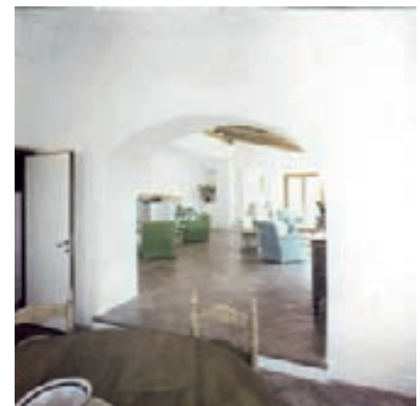
A Ein typischer Innenraum einer Villa von Vietti, mit der Dreiteilung der Fenster. In diesem Fall mit diagonal gelegten Kacheln von Cerasarda und für die Atmosphäre im Wohnraum wurden unter dem selbsttragenden Dach Holzbalken verlegt, jeder Raum ist auf einem leicht anderen Niveau. Foto 1966. (Archiv Enzo Satta)
