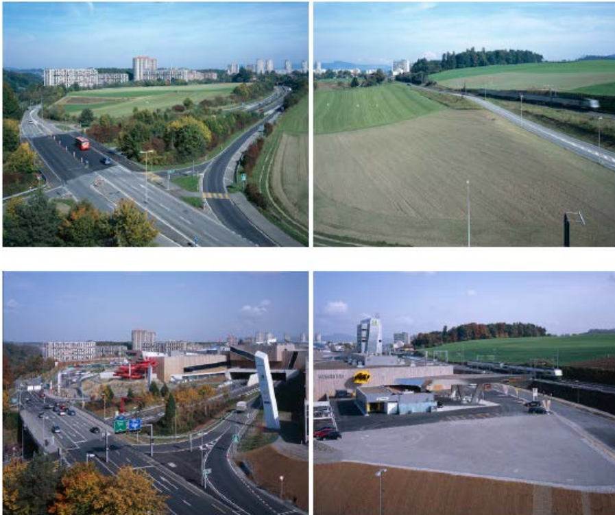
Blick (Westansicht) auf das Brünnenfeld 2002 und 2008 Documenta Natura
