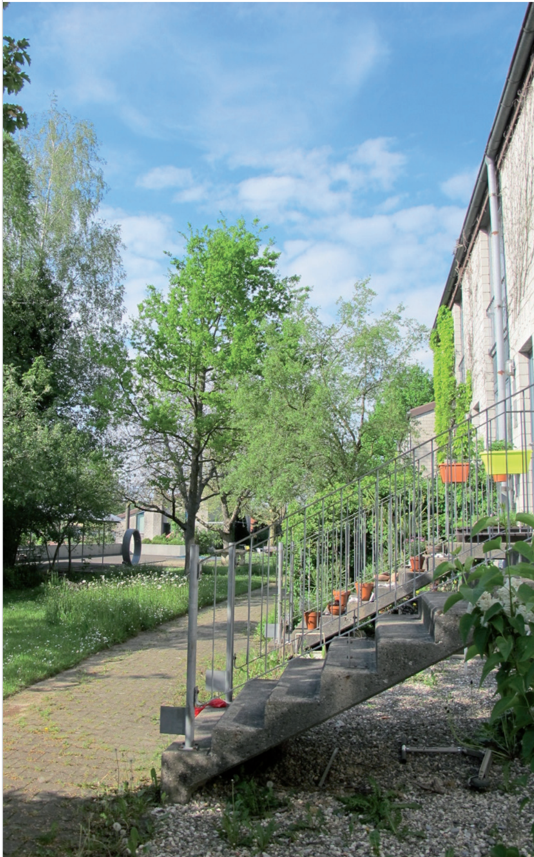
Siedlung Auf dem Höli, Schurz AG, Hauseingang (Foto: Angela Birrer)
