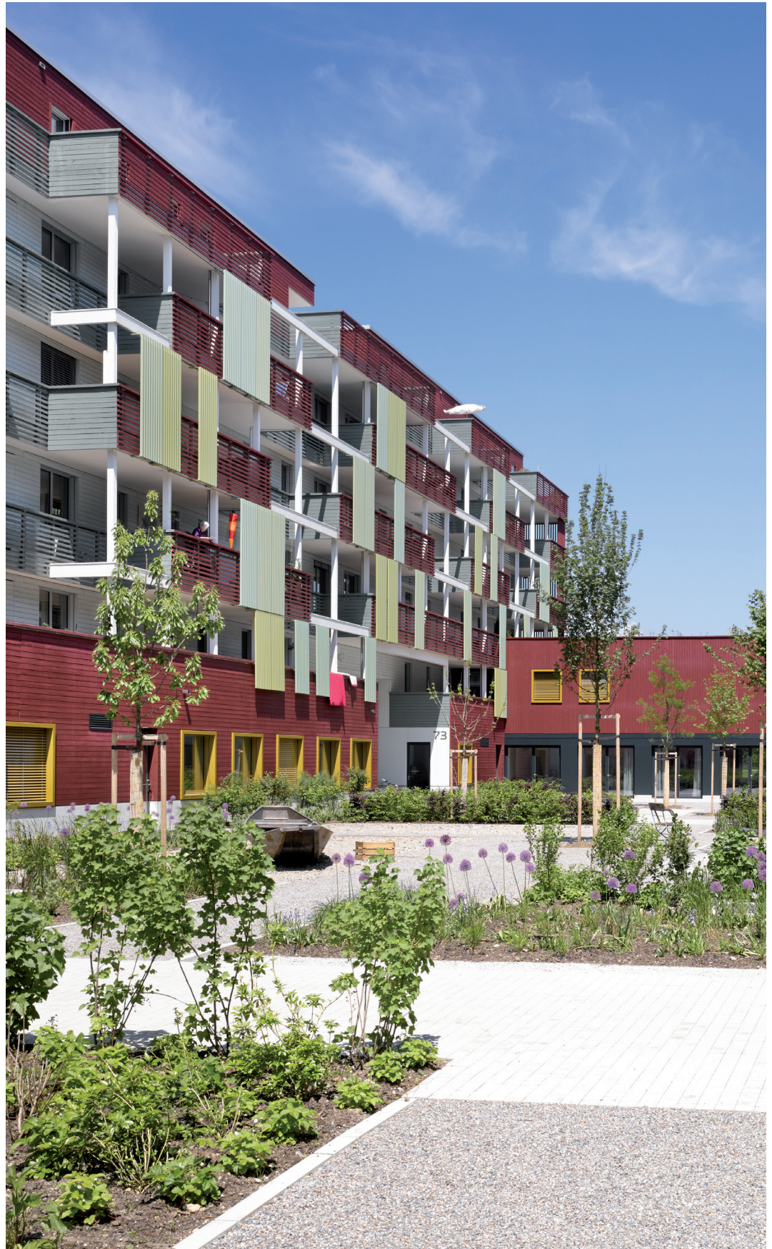
Innenhof Mehr-Generationen-Haus Giesserei, Winterthur (Foto: Hannes Henz)
