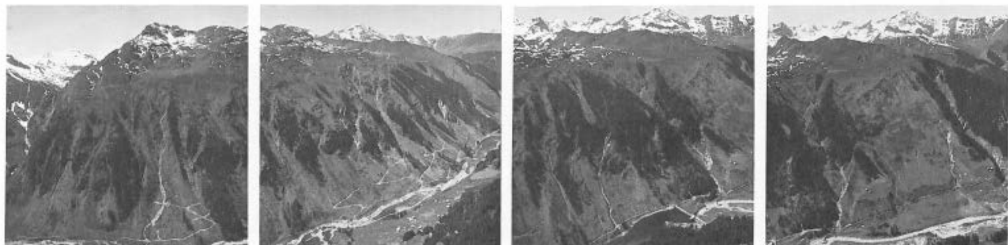
Fig. 8 Somvix, Kanton Graubünden: Zerstörung des Waldgürtels am Nordosthang durch anfangs April 1975 oberhalb der Waldgrenze angebrochene Lawinen, größter zusammenhängender Waldschaden dieser Lawinensituation mit 11 000 m 3 geworfener Holzmasse. (Flugaufnahme E. Wengi, EISLF)
