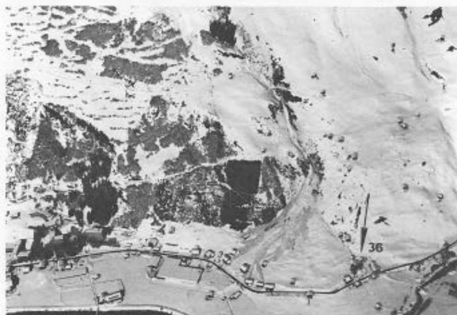
Fig. 42 Die Unglücksstelle von Camp (Nr. 36) und die in gefährliche Nähe der Wohnhäuser vorgedrungenen nördlichen Lawinenarme der Matte-Lawine (Nr. 38), Foto SLP
