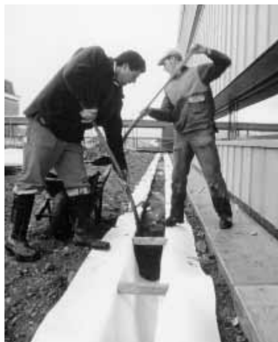
Abbildung: Adsorbentstreifen rund um den Neubau des Eidgenössischen Amtes für Messwesen (EAM) in Bern. (Foto: EAM)
