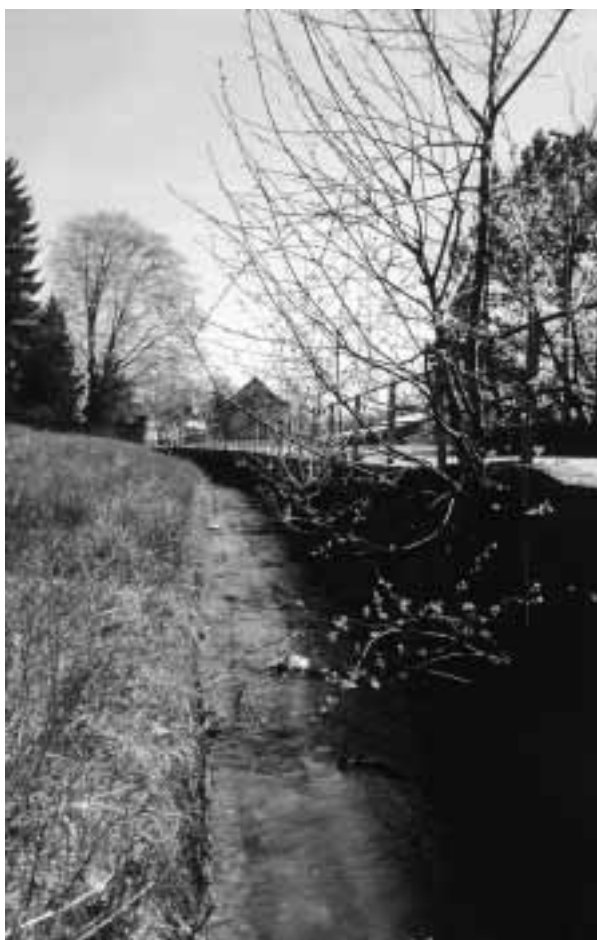
Abbildung 3: Der verbaute und begradigte Sagentobelbach bei Stettbach/Dübendorf.
