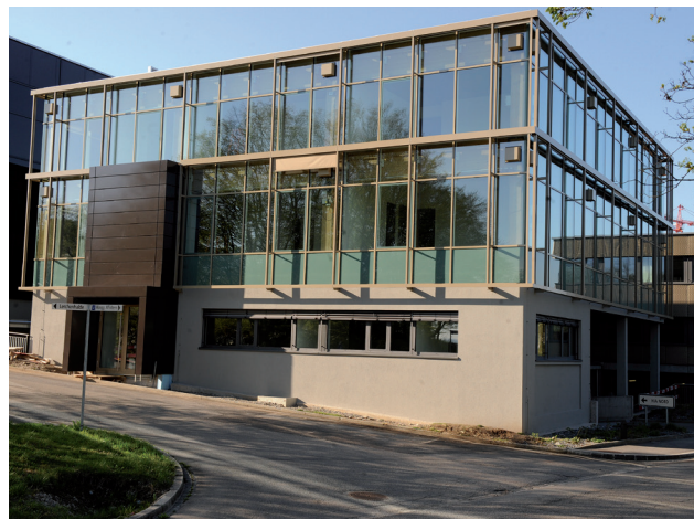
Fig. 2: Das «House of Natural Resources» auf dem Campus ETH Hönggerberg. The «House of Natural Resources» at ETH campus Hönggerberg.
