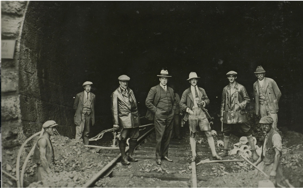
Unbekannt: Bischofshofen – Hüttau, Bahnkabellegung 1928, Zell am See - Salzburg, Ing. A. Spritzer, Aktiengesellschaft für Bauwesen
