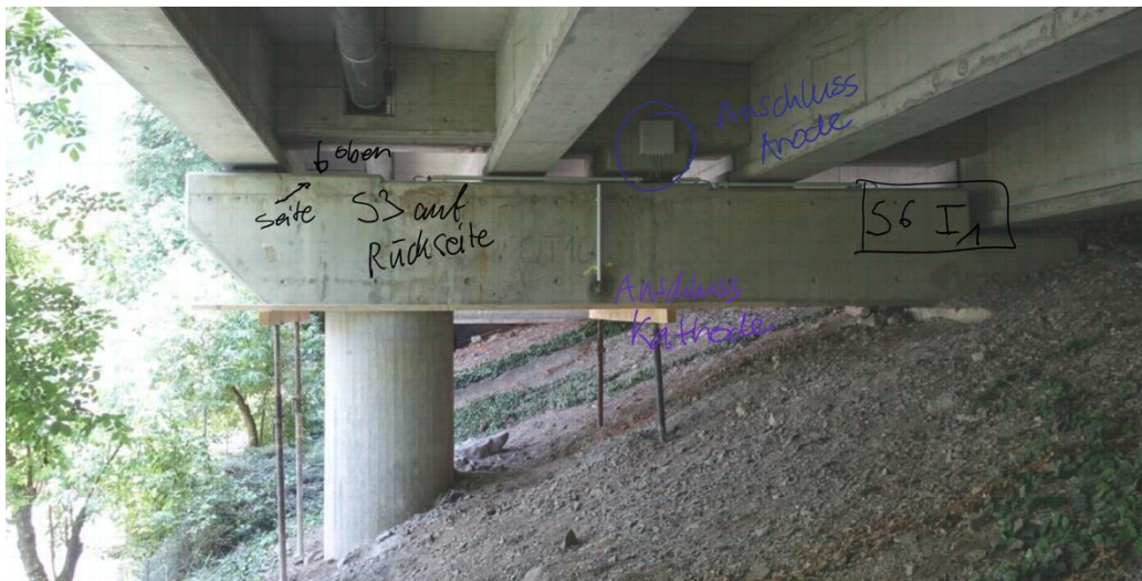
Abb. 13 Querträger und Stütze unter der Brücke in Hergiswil, in welcher sich das hier verwendete Monitoringsystem befand.
