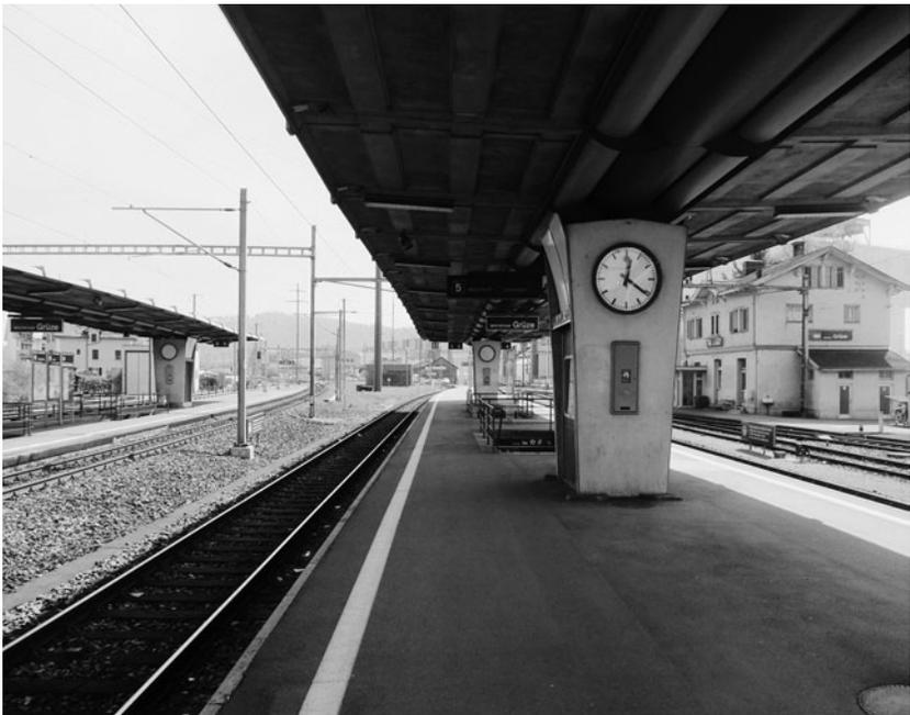
Hans Hilfikers Perrondächer im Bahnhof Winterthur Grütze im Zustand April 2010. Dank dem selbsttragenden zentralen Rohr genügten drei Stützen für das ganze Perrondach.
