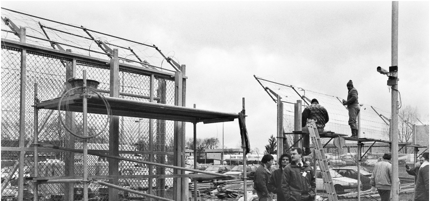
Abb. 4: Bauarbeiter arbeiten 1994 am Zaun des Ausschlaffungsgefängnisses.
