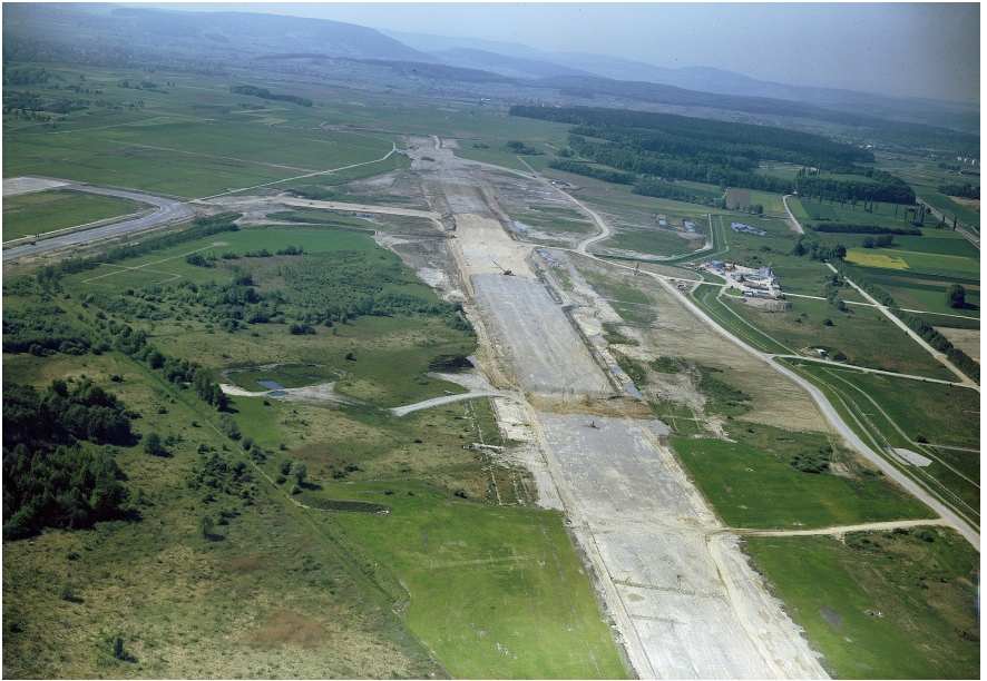
Abb. 5: Bau der Piste 14/32 quer durch die beim Erstausbau noch verschonte Moorlandschaft im Juni 1974.
