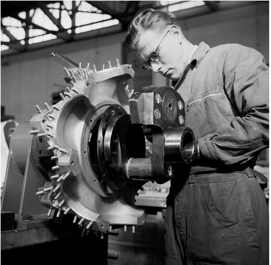
Abb. 5: Revision eines DC-3 Motors in der Motorenwerkstatt Dübendorf, ca. 1937–1948.
