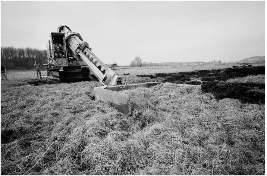
Abb. 4: Ein Spezialbagger (Gradallbagger) gräbt im Frühling 1973 mit dem Teleskopausleger behutsam ein zur Verpflanzung bestimmtes Stück Moor aus.
