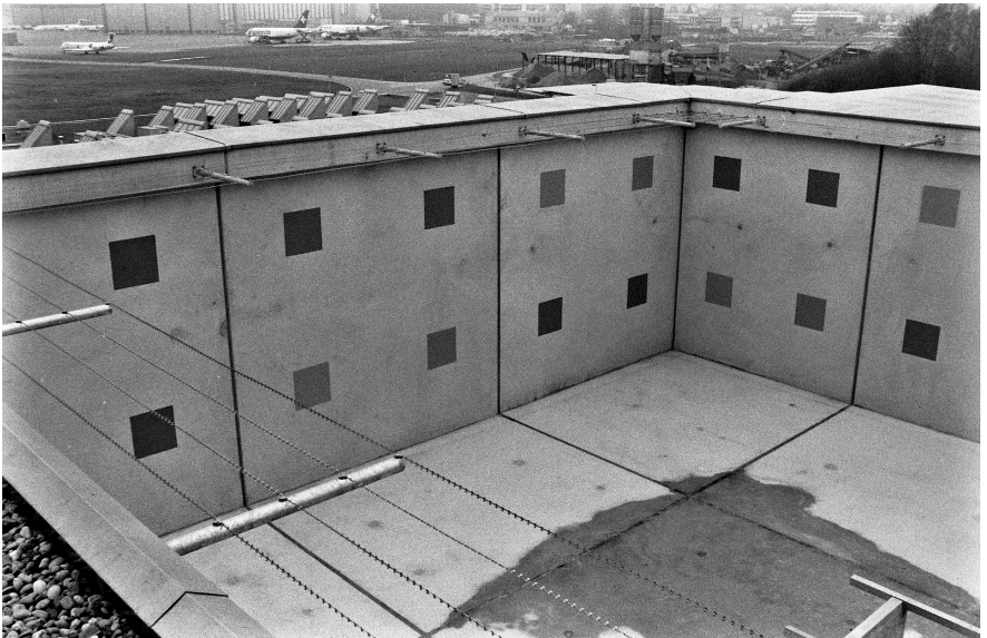
Abb. 6: Innenhof des Ausschaffungsgefängnisses in Kloten mit Blick auf Swissair-Flugzeuge im Hintergrund, 1996. Die Fluggesellschaft führte vor ihrem Grounding regelmässig Ausschaffungsflüge durch.
