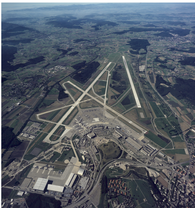
Abb. 6: Blick aus dem Süden auf den Flughafen im Ausbautzustand von 1977. Links im Bild ist die begradigte Glatt erkennbar, daneben die Waldstücke, die nach dem Bau des Flughafens übrig blieben.
