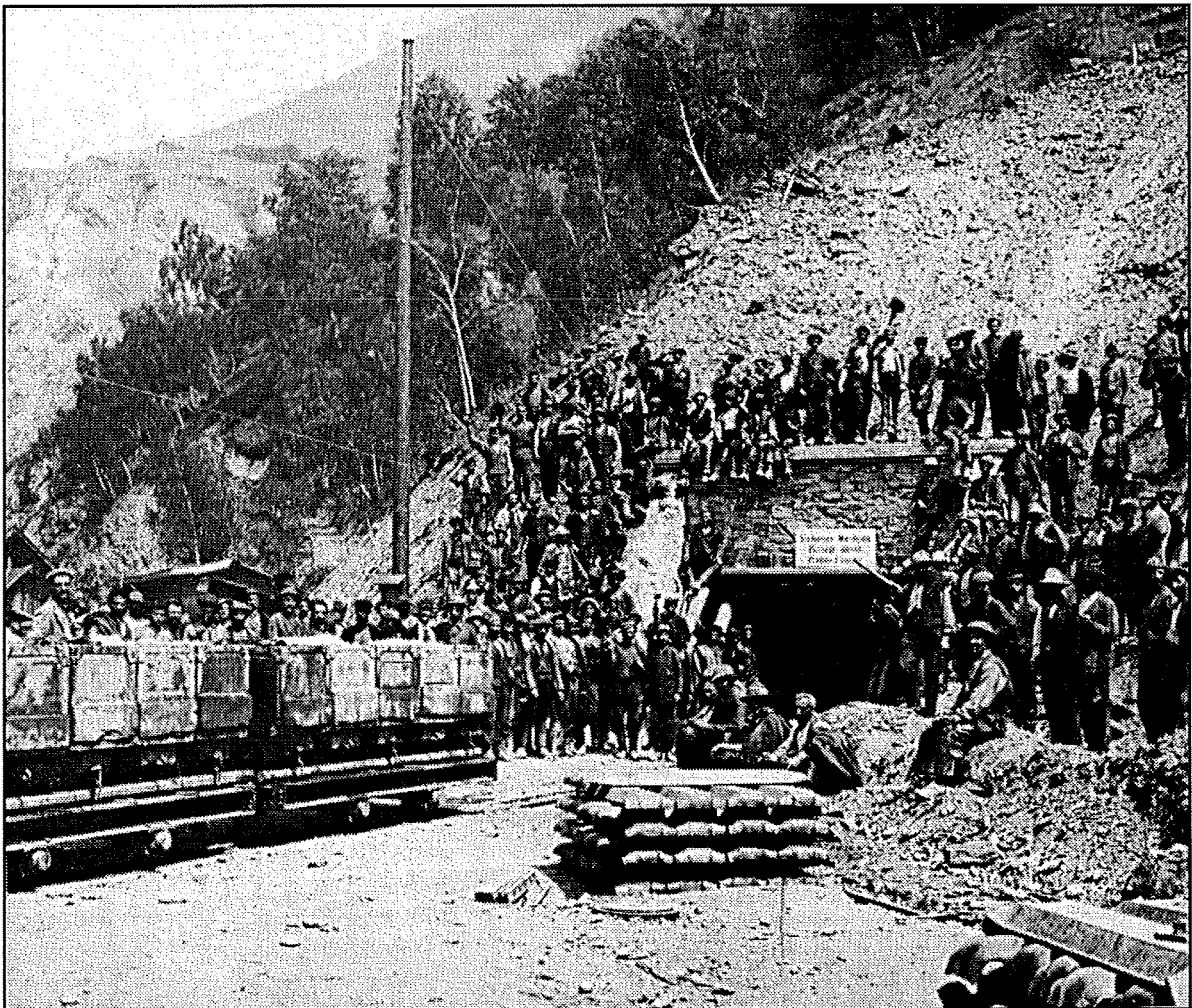
Bild 4: Arbeitspause der Tunnelarbeiter vor dem Stolleneingang. Links zwei Wagen der Bahn mit Tunnelaushub
