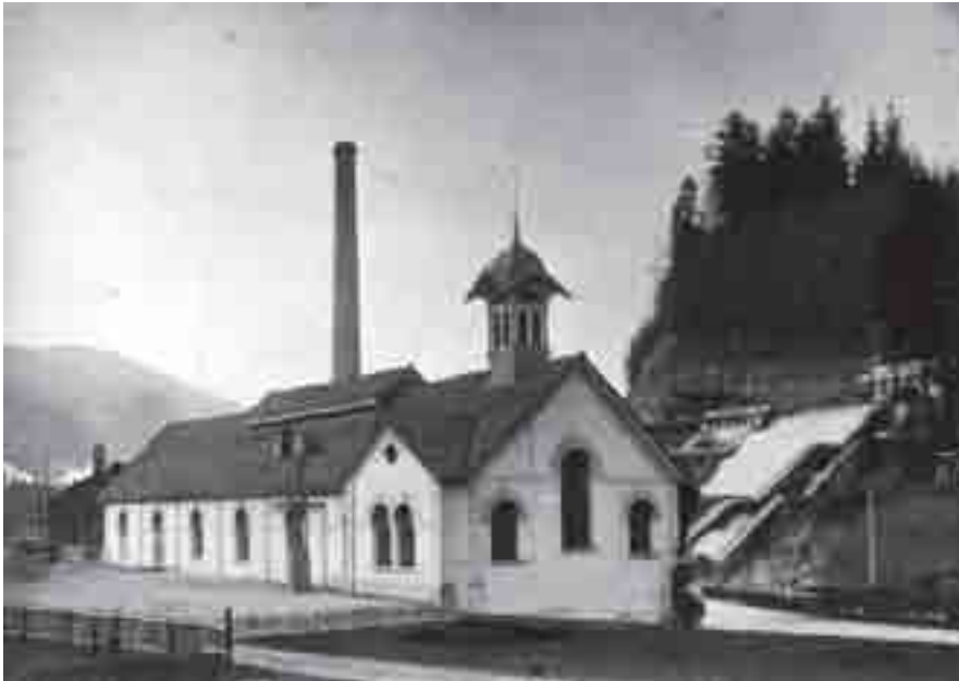
Abb. 1: Elektrizitätswerk Thorenberg. Stadtarchiv Luzern.
