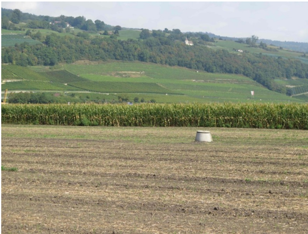
Bild 1: Torfsackung auf einem Acker bei Créssier NE (Photo: Cédric Bader). Das Bild zeigt einen Schacht, der einen Meter über den Ackerboden hinausragt. Dieser Schacht ist Teil der Entwässerungsinfrastruktur und war vor Jahrzehnten noch ebenerdig. Grund, dass dies nicht mehr so ist, ist die sogenannte «Torfsackung».
