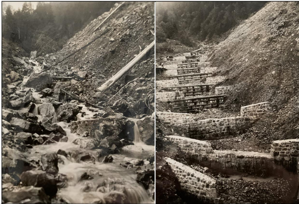
Abbildung 7: Fotovergleich vor (links) und nach (rechts) den Arbeiten am Butzibach im Jahr 1933 43 .
