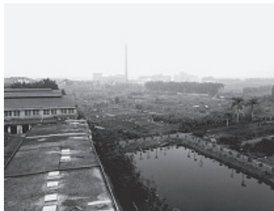
Frühjahrssemester 2016 Sanierung einer Fabrik in Panyu, Südchina
