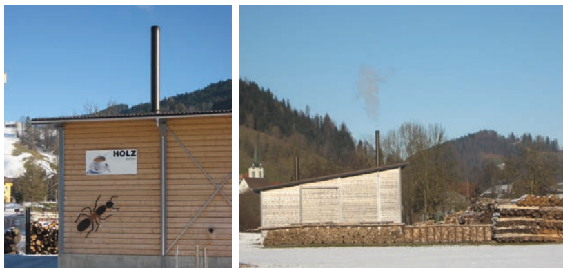
Abbildung 2 Die Holzschmelzeheizung in Urnäsch (Fotos: ETH-UNS TdLab)
