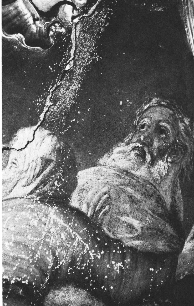
Unterer Chor der Stiftskirche EINSIEDELN: „Tochter Jephta“, Fresko von Franz Xaver Kraus und Balthasar Ripp, 1747. Pilzbefall vor allem entlang der Risse. (Foto O. Emmenegger)
