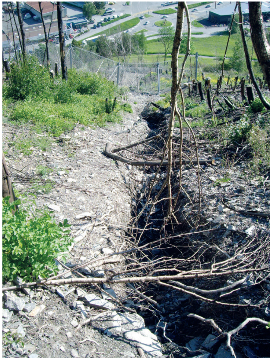
Abb. 6. Grabenerosion nach Waldbrand in Visp (Foto: M. Conedera)
