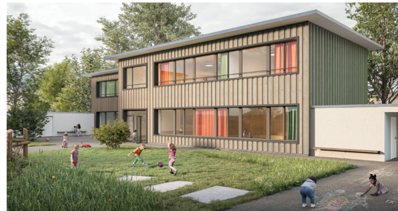
Fig. 4.3.11B: Repair and adding of storeys of Kindergarten Meilen (Gemeinde Meilen 2022)
