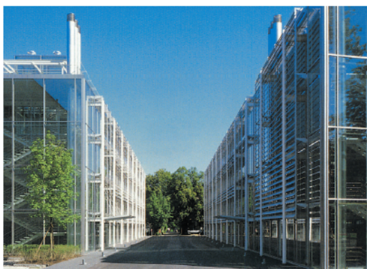
Abb. 34: Im Aussenbereich stehende Stützen bei der Gewerblich-Industriellen Berufsschule Bern (GIBB)
