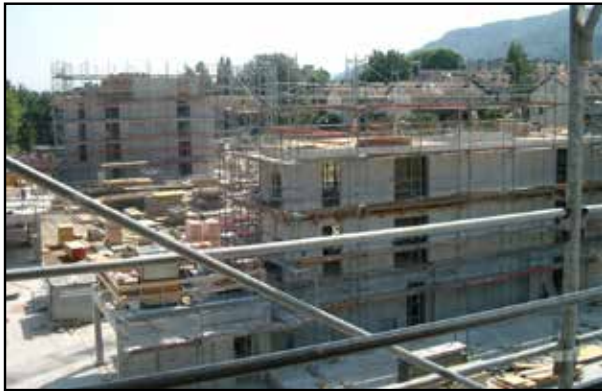
Blick auf die Betonkerne
