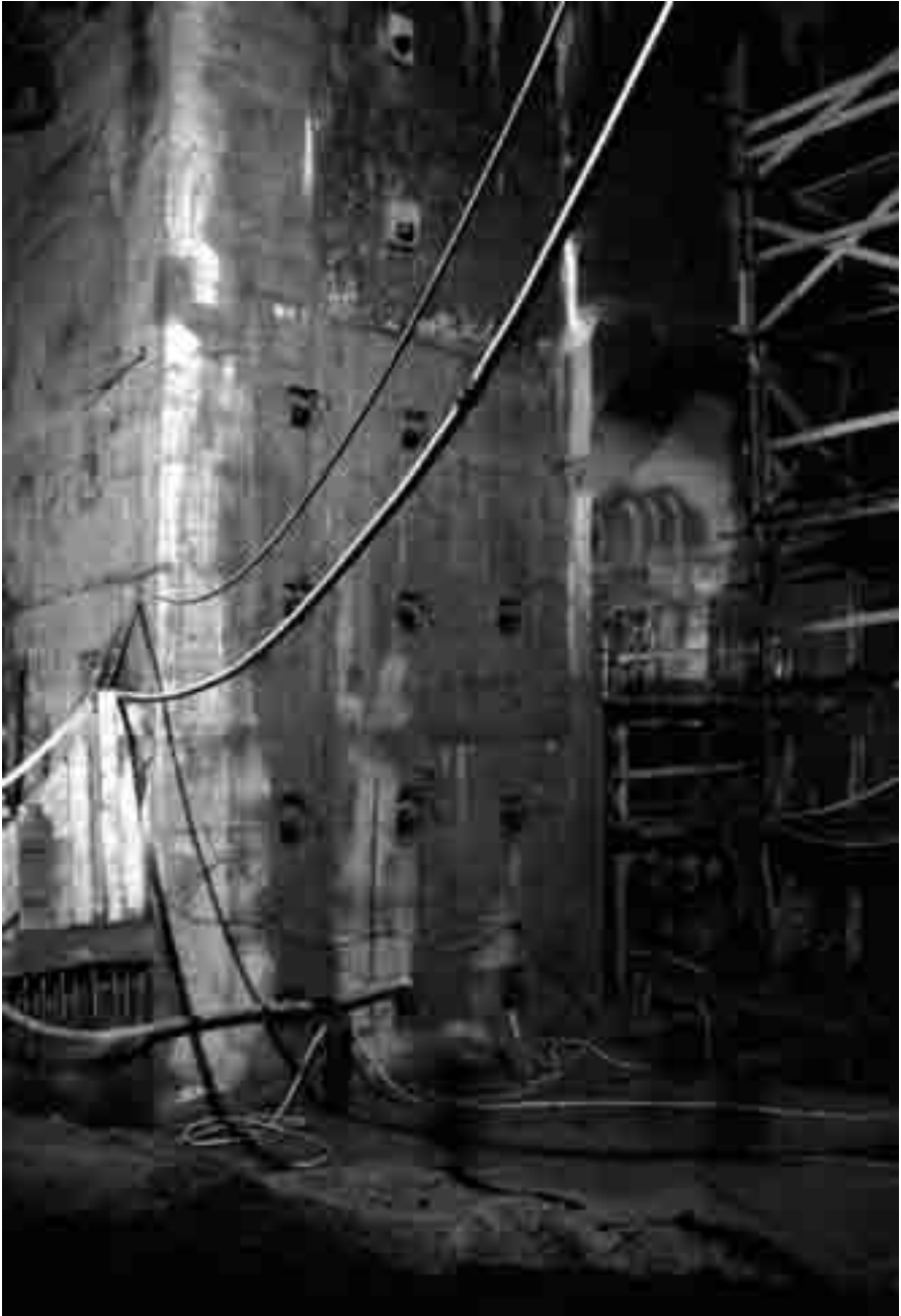
Abb. 20: Der angerissene Zentralpfeiler zwischen Reaktorkaverne und Stablager, nachdem er mit Ankern vorgespannt wurde (AKS, Nachlass Ribaux, 322.6).
