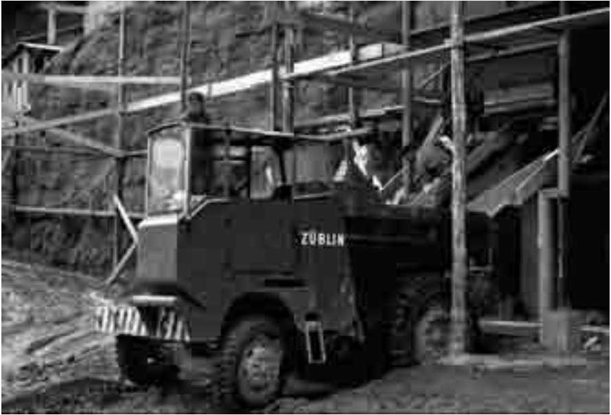
Abb. 16: Betonierarbeiten am Zugangstollen von Lucens (AKS, Nachlass Ribaux, 322.6).
