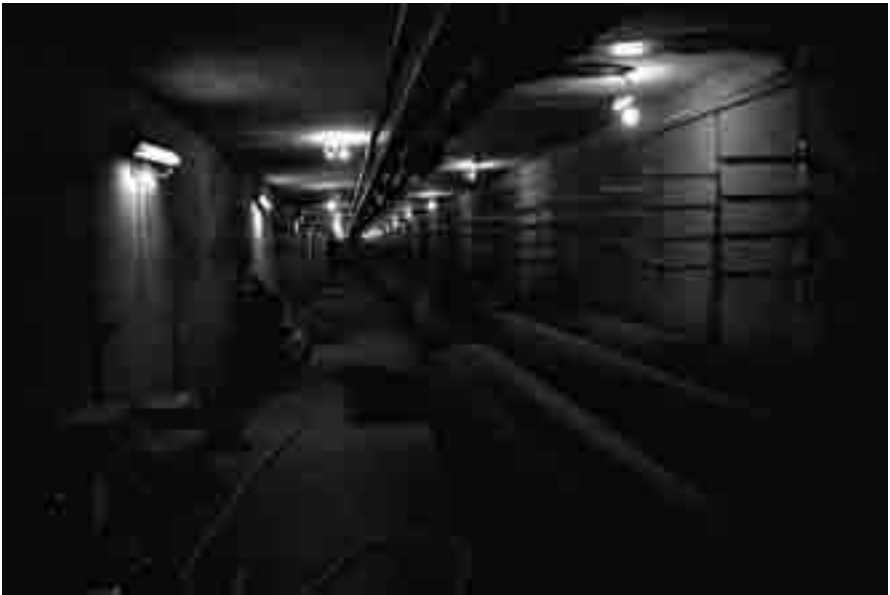
Abb. 18: Zugangstollen zur Lucens-Reaktorkaverne (AKS, Nachlass Ribaux, 322.6).
