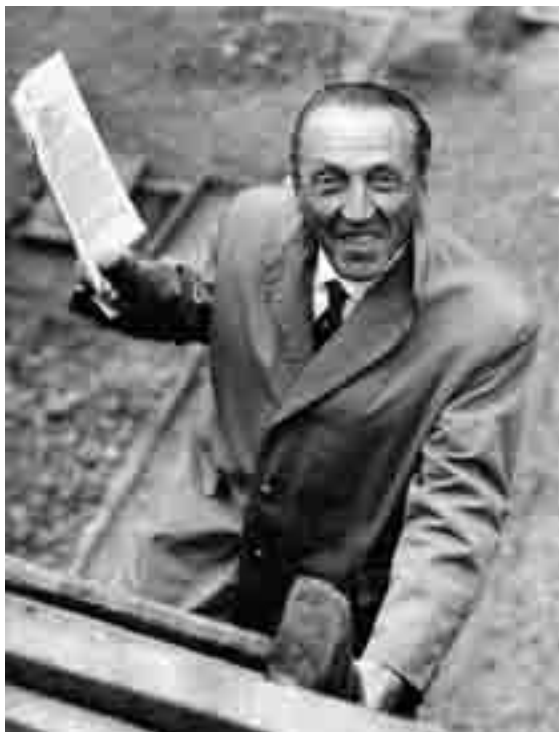
Abb. 2: Prof. Paul Scherrer bei der Grundsteinlegung der Reaktor AG 1956 (ArBBC).
