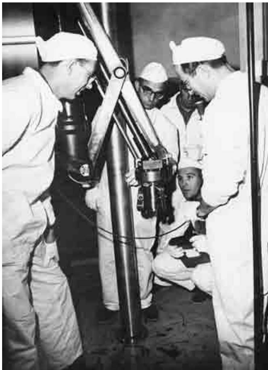
Abb. 8: Lademaschine für den Dragon-Reaktor der OECD, gemeinsam gebaut von Sécheron und Charmilles (AKS, Nachlass Ribaux, 22413)
