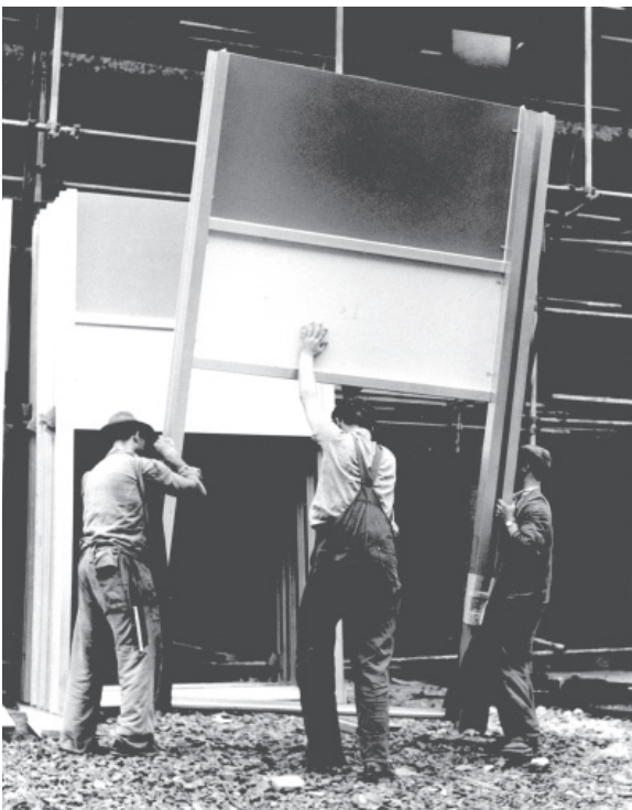
133-134 Montage der einzelnen Fassadenelemente am Rohbau
