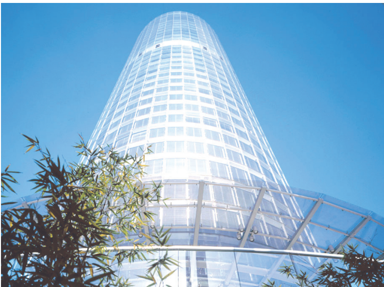
191 Hauptverwaltung der RWE AG in Essen, 1997
