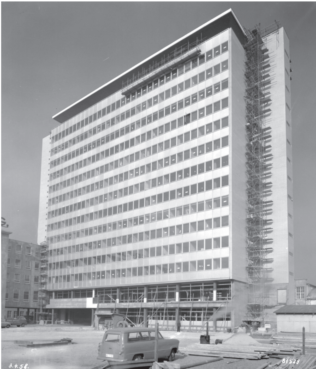
137 Fassade des Hochhauses der Daimler-Benz AG in Stuttgart mit ‚MANNESMANN-Panels‘, 1958
