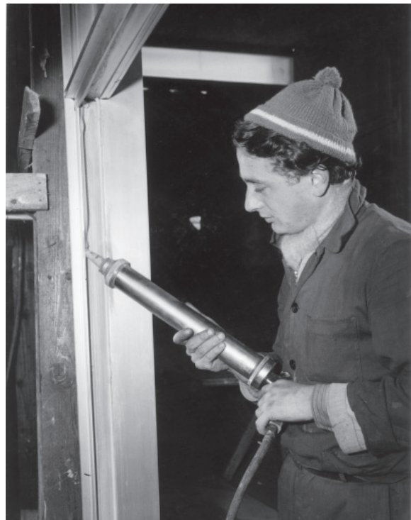
130-131 Abdichtung der Fassadenelemente des Mannesmann-Hochhauses mit Abdichtungsband und Fugenkitt
