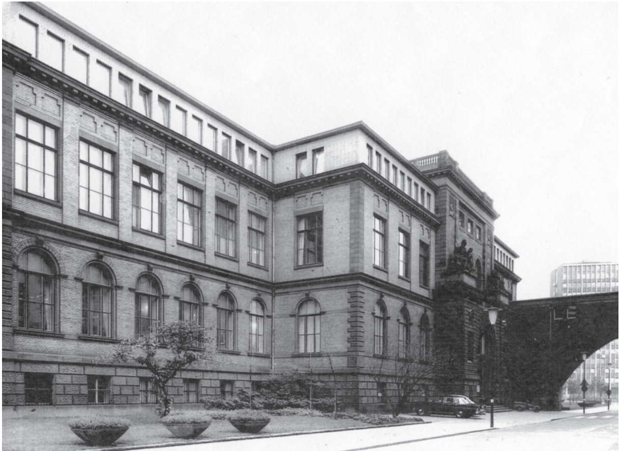
21 Hauptverwaltung der Hoechst AG nach der Aufstockung, 1960
