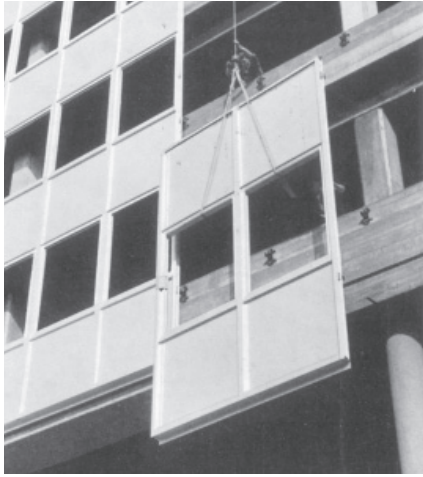
136 Fassadenelement des Hochhauses der Daimler-Benz AG mit ‚MANNESMANN-Panels‘
