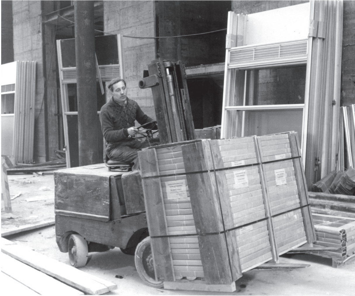
129 Lagerung und Transport der ‚MANNESMANN-Panels‘ auf der Baustelle des Mannesmann-Hochhauses
