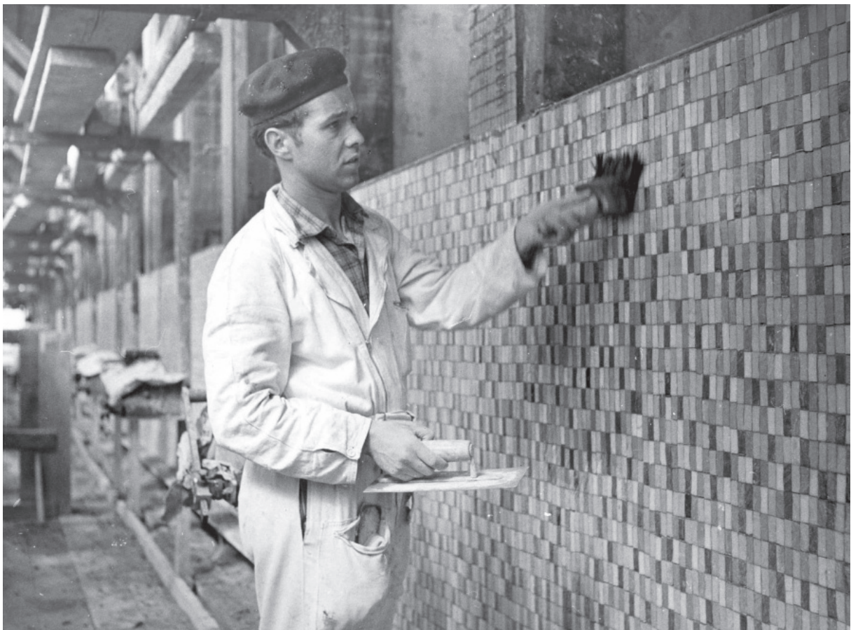
119 Verlegung der Glasmosaiken an der Fassade des Verwaltungshochhauses der BASF AG, 1956
