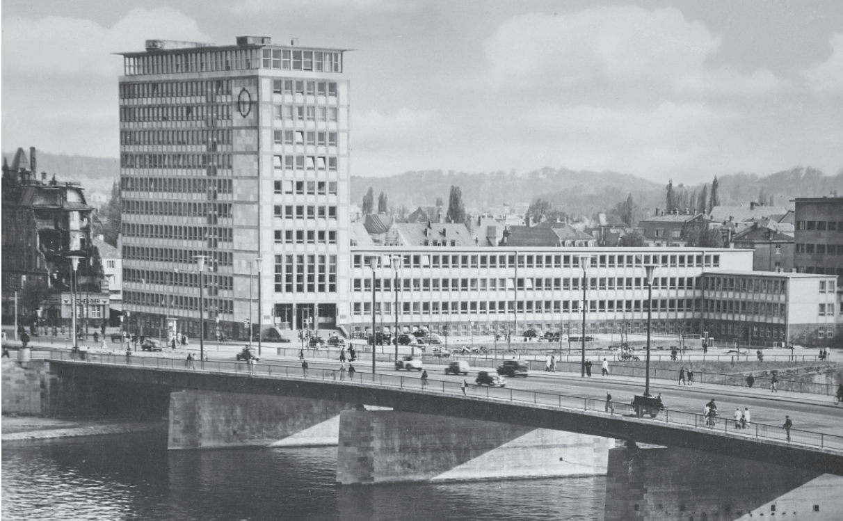
26 Westdeutsche Verwaltungszentrale der AEG in Frankfurt a. M. (1949-1951)
