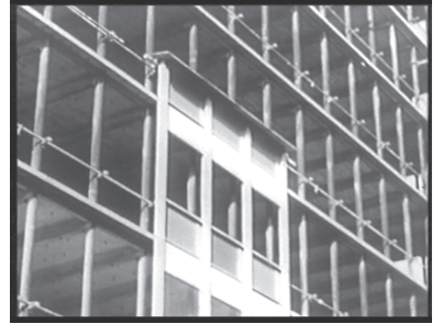
175 Montage der Fassadenelemente, Standbilder aus dem Film ‚Das Mannesmann-Hochhaus in Düsseldorf‘, 1959
