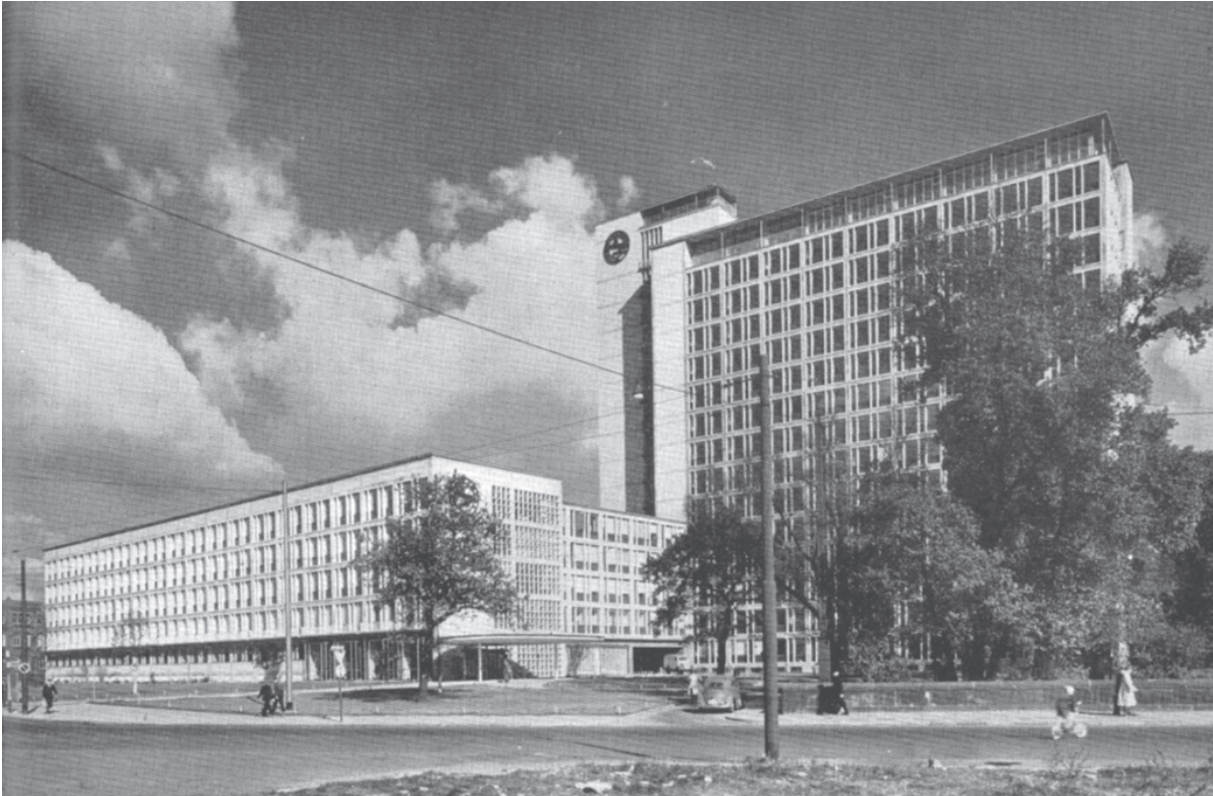
34 Hauptverwaltung der Continental AG in Hannover mit Direktionsgebäude und Verwaltungshochhaus, 1953
