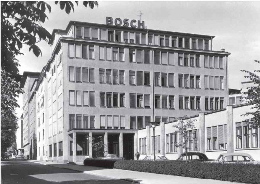
13 Hauptverwaltung der Robert Bosch GmbH nach der Instandsetzung, 1963
