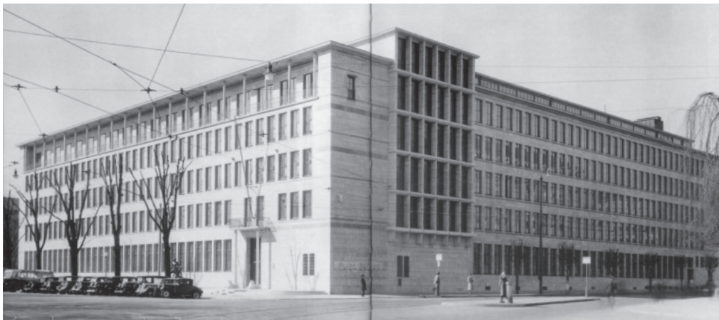
113 Verwaltungsgebäude der Schweizerischen Lebensversicherungs- und Rentenanstalt in Zürich (1937-40)
