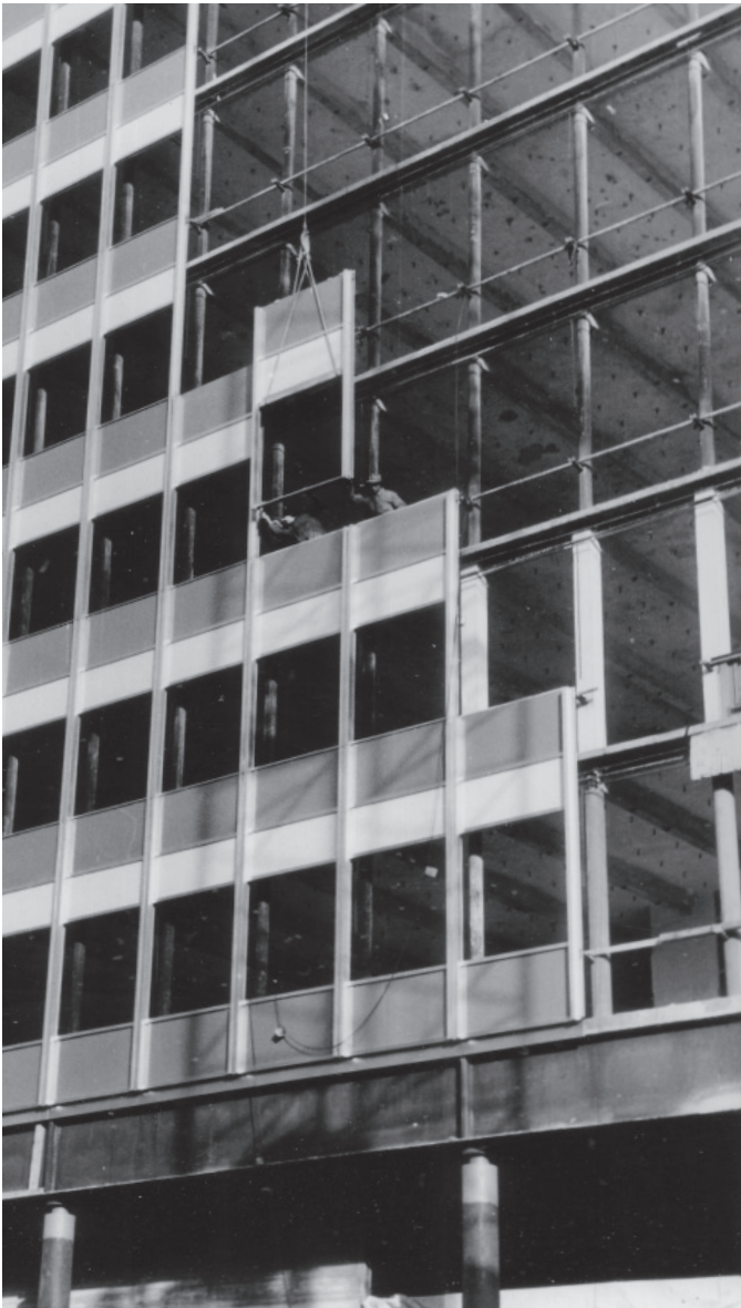
104-105 Einsatz des Baustoffs Stahl beim Bau des Mannesmann-Hochhauses: Mannesmann-Stahlrohr mit Bewehrung vor dem Ausgießen mit Gips, Versuchsaufbau in der Bundesanstalt für Materialprüfung (o.), Tragwerk aus Mannesmann-Stahlrohren (teilweise noch ohne Gipsummantelung) mit Fassade aus ‚MANNESMANN-Panels‘ (u.)
