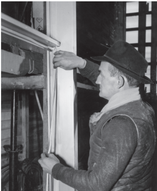
130-131 Abdichtung der Fassadenelemente des Mannesmann-Hochhauses mit Abdichtungsband und Fugenkitt
