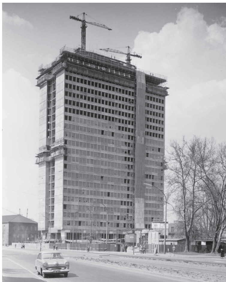
88-89 Verwaltungshochhaus der BASF AG, Betonieren einer Geschoßdecke, 1955, und Stahlbetontragwerk, 1956
