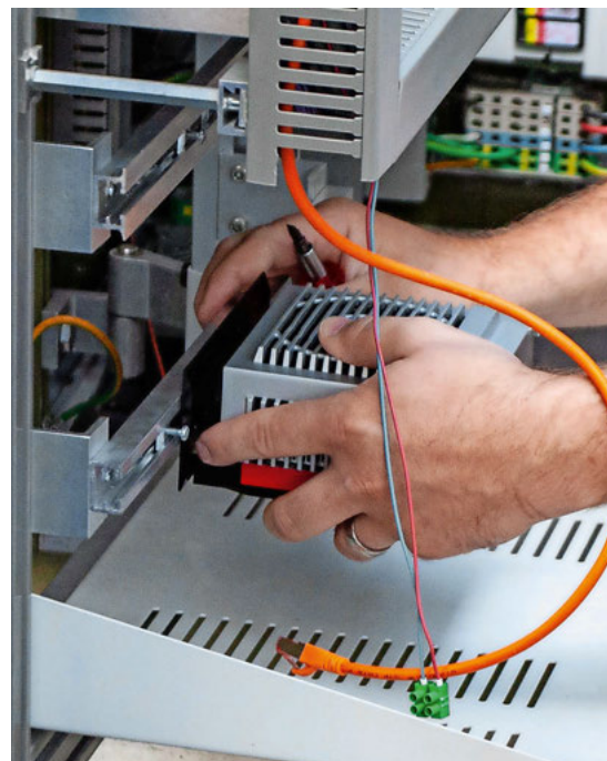
6 | Einbau des Industrie-PCs in den Steuergeräteschrank.
