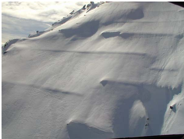
Abbildung 2: Randvoll - überschneite Stützverbauungen bei Landarenca im Calancatal/GR (Foto: Sven Fehler, 15.3.2001).
