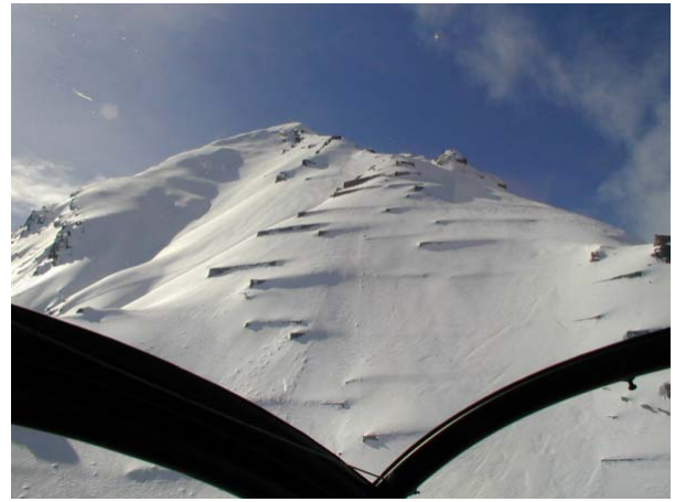
Abbildung 24: Lawinerverbauungen bei Landarenca im Val Calanca/GR am 28.2.. Die Verbauungen, betrachtet aus dem Helikopter, waren randvoll. Grössere Abgänge oder Schäden wurden auch im weiteren Winterverlauf nicht gemeldet. Die Schneedecke war an benachbarten Sonnenhängen derselben Höhenlage auf dem Boden langsam gegelitten und teilweise auch abgerutscht. Die Gleitschneerisse waren noch lange sichtbar (Foto: Sven Fehler).
