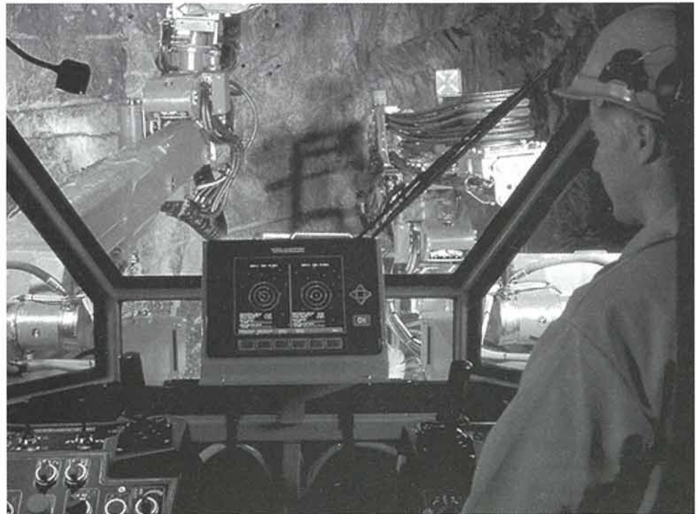
8 Computerunterstütztes Bohren von Sprenglöchern (Quelle: Atlas Copco)
