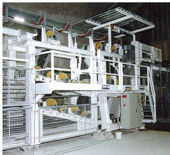
7 Bandspeicheranlage – Anschlußstollen Glatt (Quelle: Rowa)
