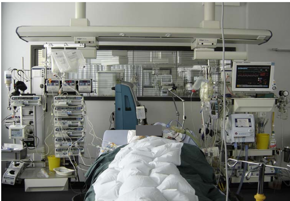
Abb. 100 Patientenbettplatz der neuen Intensivstation. Deckenversorgungssystem mit schwenk- und verschiebbaren Gerätesäulen.
