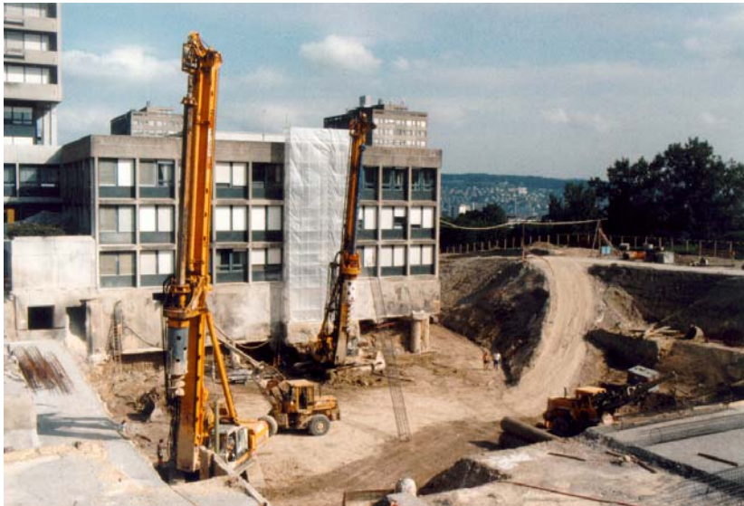
Abb. 77 Baugrube des geplanten Neubaus zu Beginn der Ergonomiestudie. Das bestehende Gebäude wird durch den Neubau um 55 m verlängert.
