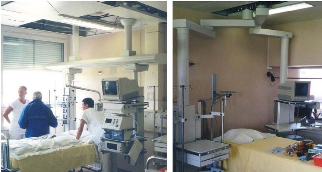
Abb. 92 Probeweise Installation zweier Deckenversorgungssysteme als Entscheidungshilfe. Die Installation war ein Service der am Auftrag interessierten Systemhersteller.
