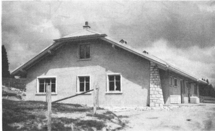
Par une conduite aérienne traversant l'étable (on la distingue sur la photographie), l'eau récoltée sur les deux pans du toit peut être amenée aussi bien dans la citerne et les bassins sis devant le chalet que dans la fosse à purin.
