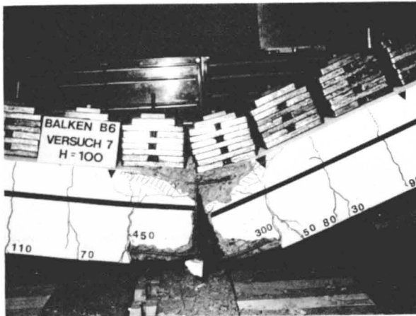
Vorderseite, x = 3.20 m Bereich der grössten Beanspruchung
