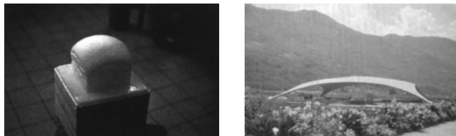
Bild 6.18: Formfindung nach der Fließmethode.
