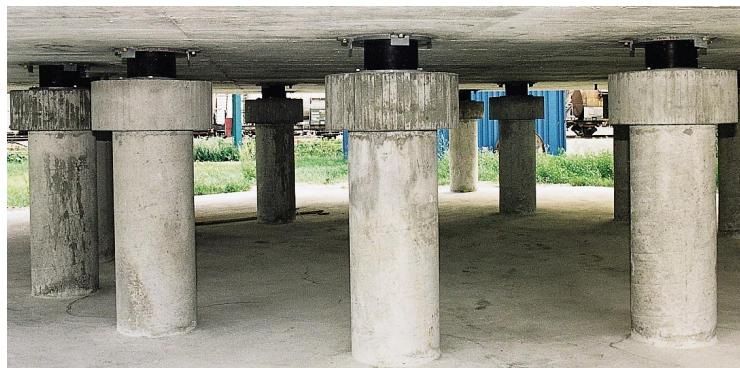
**Bild 9 - Ansicht von Stützen mit Erdbebenlagern (oben) und neuer Stahlbetonplatte (unten) nach der Erdbebensanierung**
