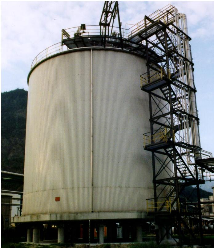
*Bild 1 - Grosstank zur Lagerung von 1000 Tonnen Flüssiggas mit Treppen- und Leitungsturm*
