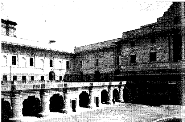
Abb. 224: Edwin Landseer Lutyens, Viceroy's House in New Delhi, Südfassade Kücheingang, 1931.
