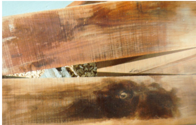
Abbildung 9: Verfärbung von Holz durch unsachgemässe Lagerung
