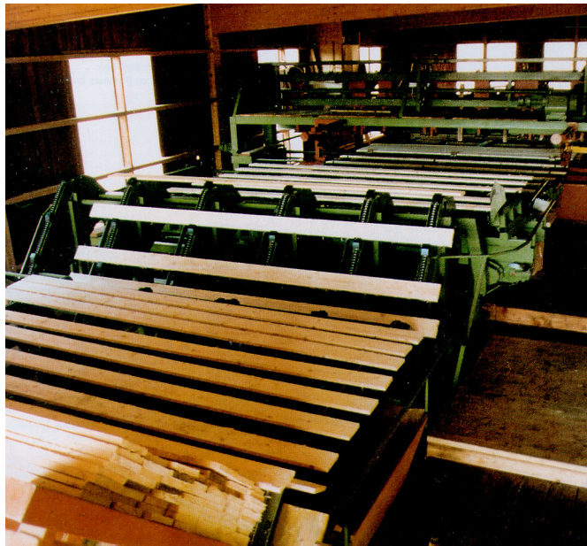
Abbildung 27: Stapelanlage, Fa. Balz, Langnau i.E./CH
