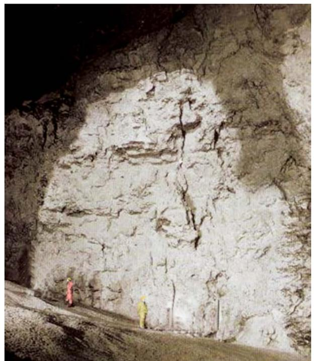
Abb. 11.18: Ausschnitt aus der Wand der A.F. Lindner-Halle mit einzelnen Nischen, die durch Kluffversagen entstanden sein können. (Foto: Halupca)
